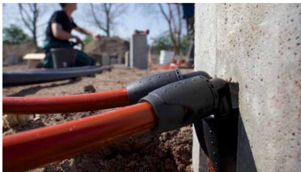
Heipaal: tegelijkertijd energiebron.
